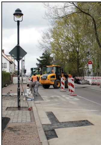
2016: Ausbau der Bushaltestelle Am Waldrand. Foto: Gabriele Bräunig
