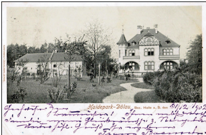
Villa im Haidepark als Firmen- und Wohnsitz von Ingenieur Willy Büsching auf einer Ansichtskarte um 1900. Foto: privat
