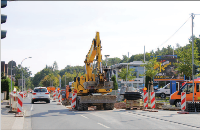
Bis Ende 2019 soll die Salzmünder Straße - vom „Kreisel“ bis zum „Heidebahnhof“ - im Rahmen von 6 Bauabschnitten komplett saniert sein. Foto: Gabriele Bräunig
