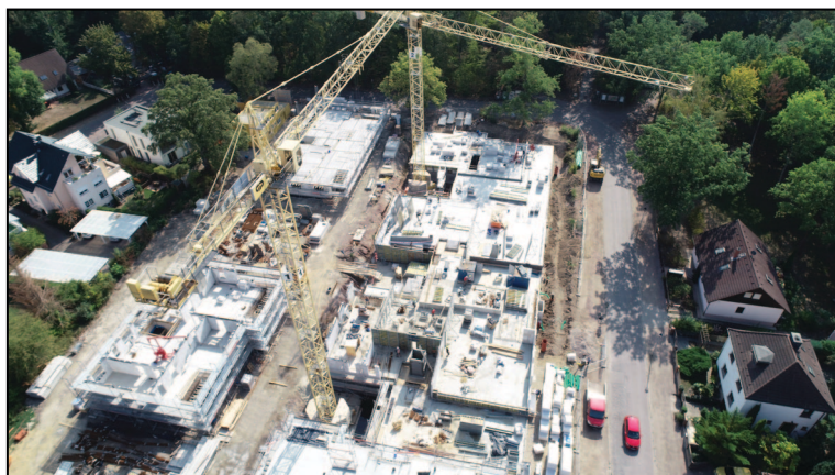
Das im August mit einer Flugdrohne aufgenommene Areal der aktuellen GWG-Baustelle im Heideweg. Foto: GWG
