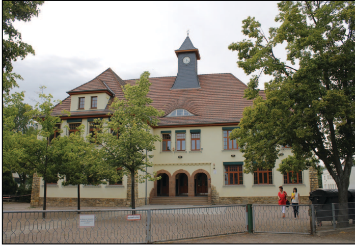
Grundschule Dölau: Im August hat die Lieskauer Firma Antec dafür gesorgt, dass es hier endlich super-schnelles Internet gibt. Foto: Gabriele Bräunig
